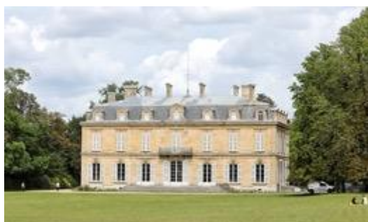
Photo © Château de Bois-Préau, RMN – Grand Palais (Musée des châteaux de Malmaison et de Bois-Préau)
